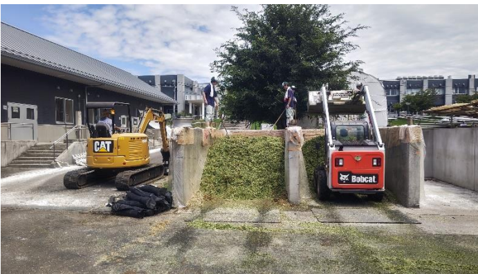
（写真：バンカーサイロへ詰め込む様子）
