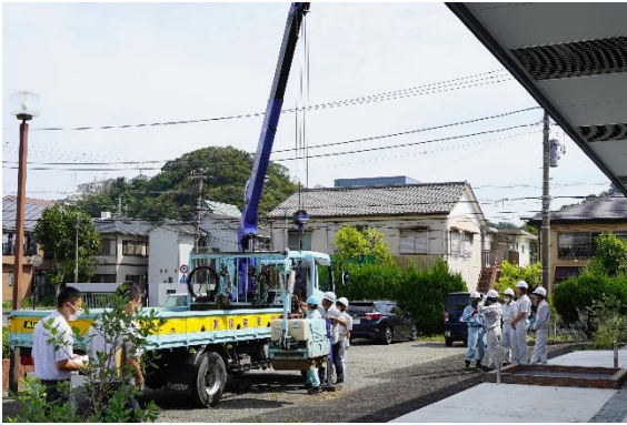
図12 トラッククレーンの取り扱い
