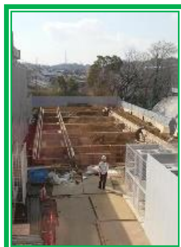
新校舎工事の様子
