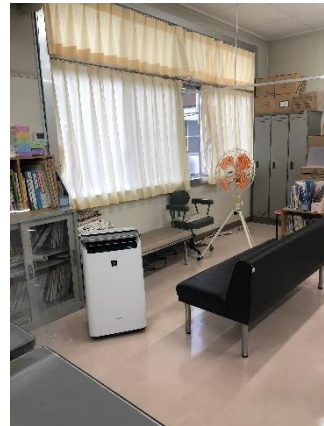
⑥空気清浄器を保健室に設置
