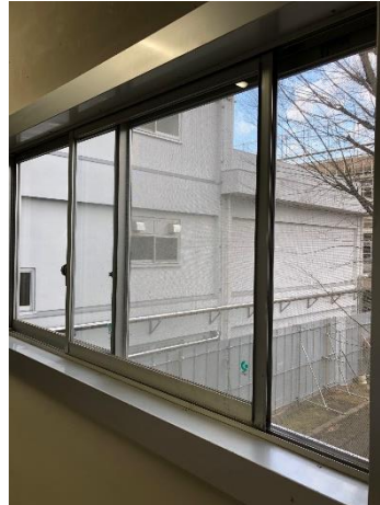
②換気のための網戸を廊下全ての窓に設置
