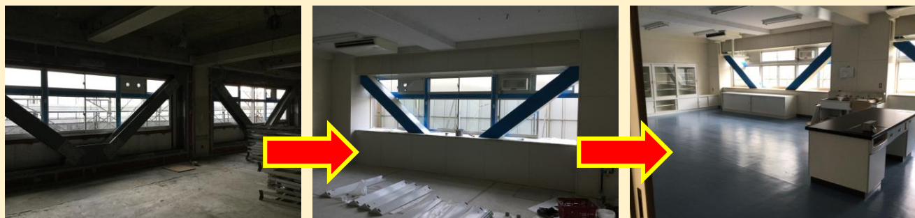
理科室にも補強ブレース設置
