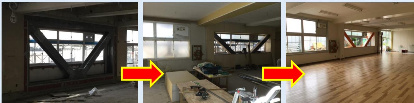
自立活動室に補強ブレース設置
