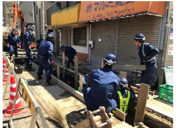
施工現場の様子
