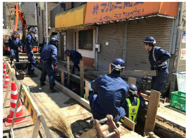
施工現場の様子
