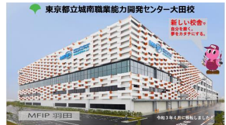
免震構造の新校舎で受講できます
