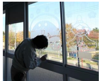
ウィンドウフィルムの施工実習
