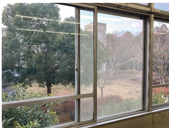
換気対策のための網戸設置
