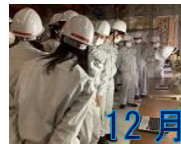
港区赤坂工事現場見学
